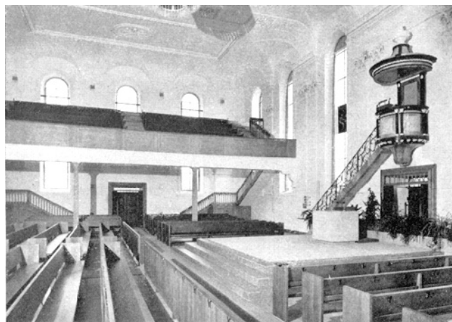
Bärethswil. Reformierte Kirche. Inneres nach der Renovation.
