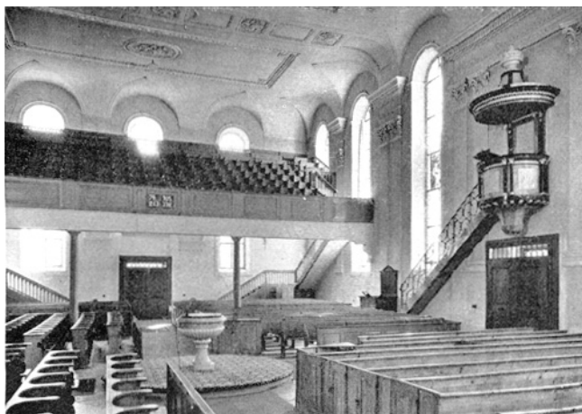
Bärethswil. Reformierte Kirche. Inneres vor der Renovation.
