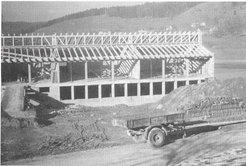
Schulhaus im Rohbau 1960
