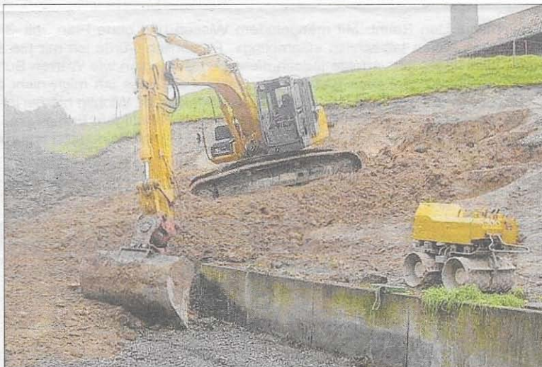
Die Baustelle beim Werkhof ist bereits in vollem Gang. (ü)
