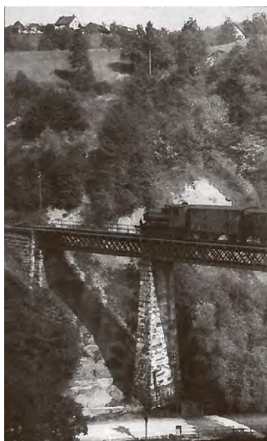
Eisenbahnbrücke im Tobel-Wald.
