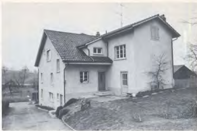
Im Oberdorf in Unterhittnau wurde an das 1883 erstellte Wohnhaus mit Schopf 1893 ein Stickereilokal angebaut, das mit Quergiebel zum Rest des Gebäudes steht.
