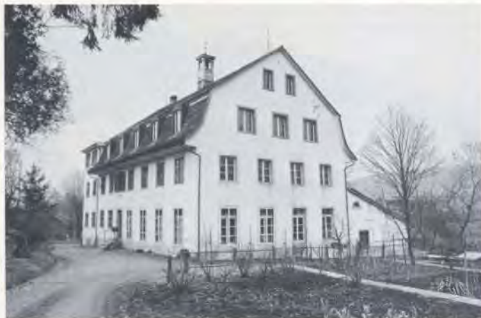
Das majestätische Gebäude im Sonnenthal in Unterhittnau entstand 1820 als Maschinengebäude mit Wohnung. Eine Zeilang wurde es als Seidenzwirnerie verwendet, von 1908 bis 1936 ist es als Wohnhaus mit Stickerei eingetragen, nachdem es durch den Einbau von höheren Fenstern für den Stickereibetrieb umfunktioniert worden war. Seit 1952 dient das Gebäude einem Bettfedernreinigungsbetrieb.
