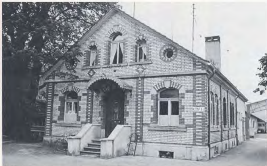
In der Firma Weber-Büeler in Kempton half Linsi beim Ausbau wesentlich mit. Der Bau entstand 1877 als Stickerei- und Webereigebäude an der Bahnhofstrasse.
