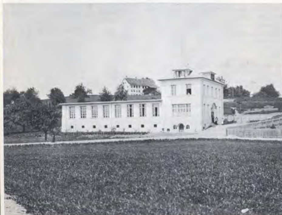
Die Schiffstickerei-Fabrik der Gebrüder Tobler wurde für zehn Maschinen dimensioniert, die in einen Saal mit Flachdach zu stehen kamen. Südöstlich schloss sich ein Hochbau für die Nachstickerei an, zuoberst befand sich eine Wohnung. Nach dem Ersten Weltkrieg verkaufte Jacques Linsi die Fabrik an die Firma Baur (später «Kaba»).
