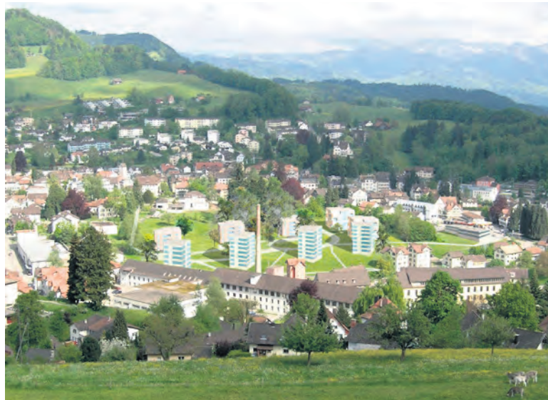
Umnutzung und Verdichtung prägen heute die einstigen Industriedörfer: Das Areal der umgenutzten Spinnerei «Bleiche» Wald mit der Visualisierung der inzwischen realisierten Neubauten der Otto & Joh. Honegger AG auf der gegenüberliegenden Seite der Jona.
