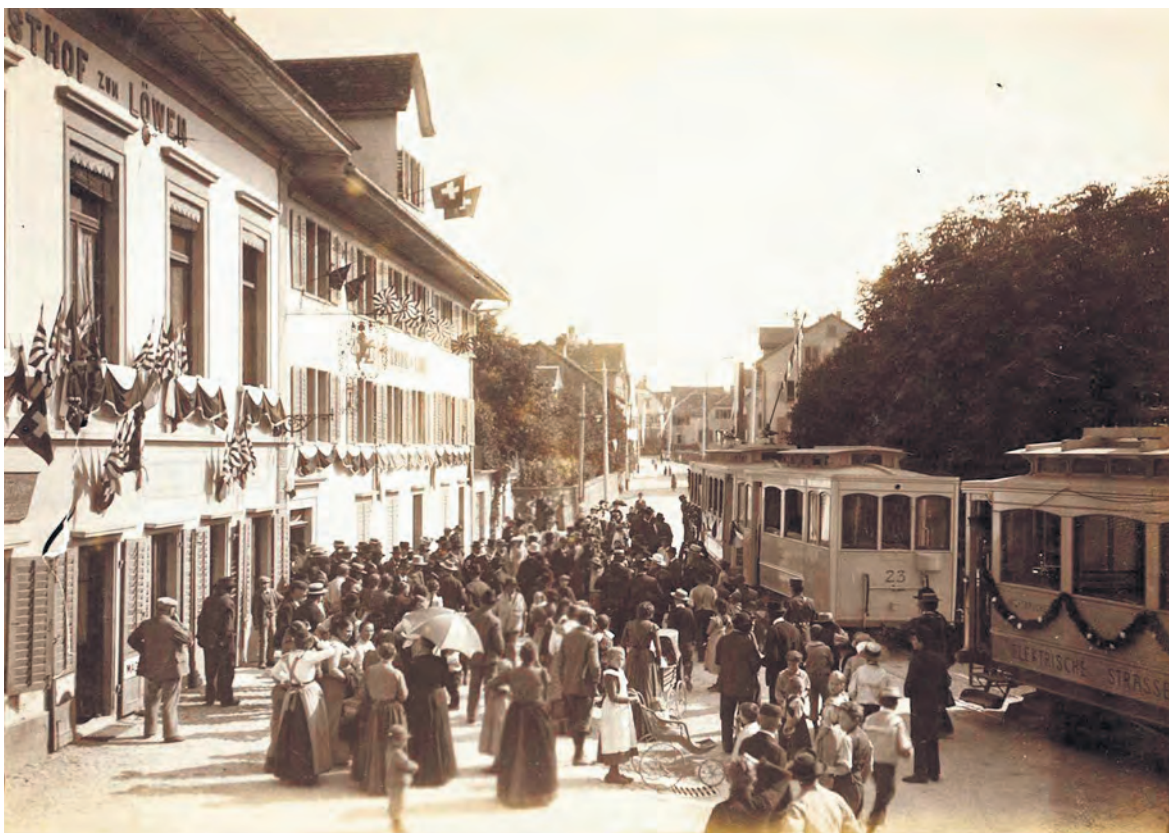
Gefeiert wurden auch noch die letzten Streckeneröffnungen, wie hier die Eröffnung der Strassenbahn Wetzikon-Meilen in Wetzikon im Oktober 1903. (Zentralbibliothek Zürich, Graphische Sammlung)
