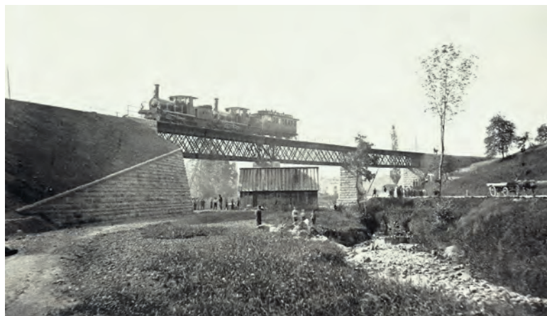
Der Wildbachviadukt der Kempttalbahn in Wetzikon während der Belastungsprobe mit zwei NOB-Dampflokotiven, wahrscheinlich 1876. Eine typische Stahlfachwerkbrücke, wie sie bei praktisch allen Eisenbahnlinien der ersten Jahrzehnte gebaut wurden. Etliche Schaulustige bestaunen das Ereignis. (Zentralbibliothek Zürich, Graphische Sammlung)
