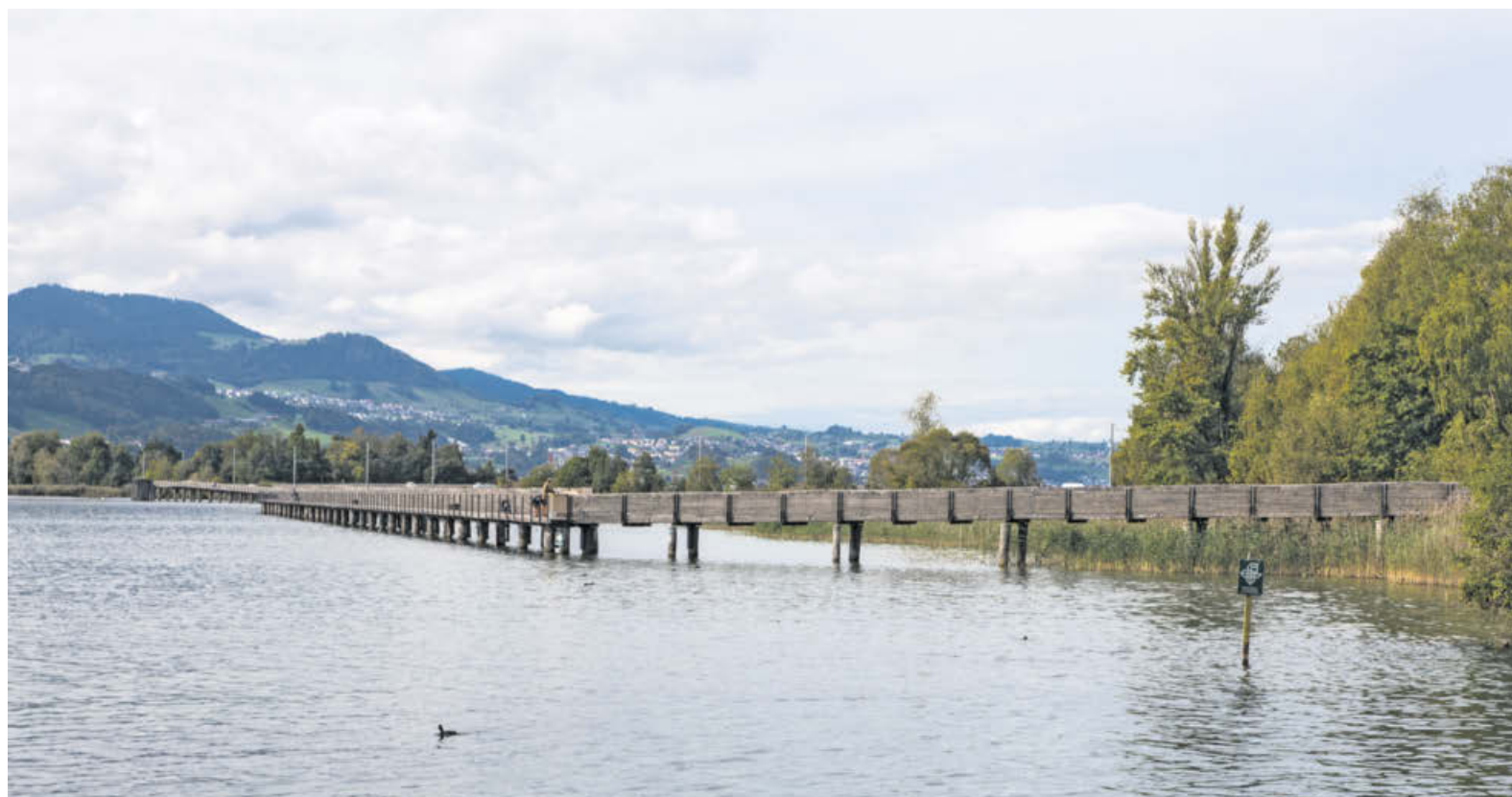
Zwischen Hurden und Rapperswil gab es schon zur Römerzeit eine Wegverbindung mit einer Brücke. Im Bild der 2001 erstellte Steg. (Foto: Marcel Niggli, Oetwil am See)
