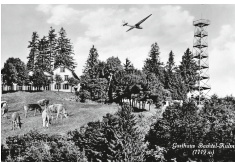
Bachtelturm von 1893: Stahlkonstruktion mit 159 Treppenstufen und einer Aussichtsplattform. (Foto: Archiv Ortsmuseum Hinwil)
