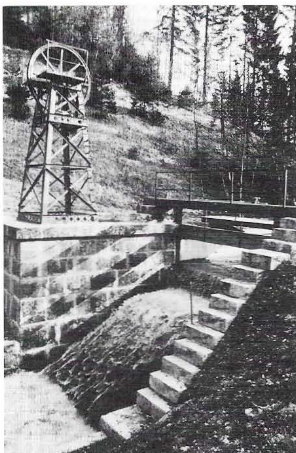
Bild 24. Unteres Wehr am Wissenbach mit Zwischenstütze der Seiltransmission, noch vor der Seilmontage
