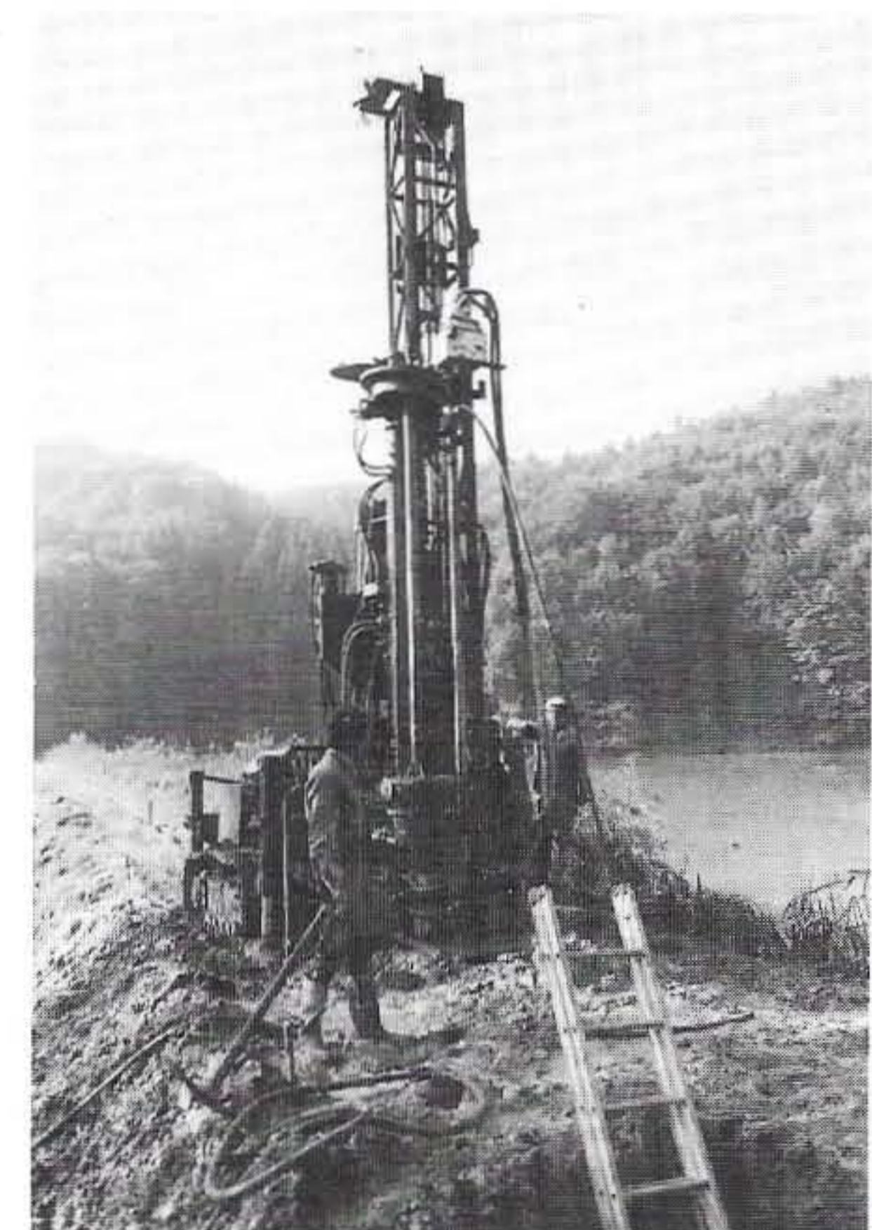
Bild 7. Modernstes Bohrergerät für die Ausführung der Jettingsäulen auf dem Erddamm Himmerichweiher. Während dem Rückzug der senkrecht in den Dammkörper gebohrten Bohrkronen wird mit hohem Druck ein Wasser-Zement-Gemisch in den Boden injiziert, welches zusammen mit dem Material des Dammes eine feste Säule bildet
