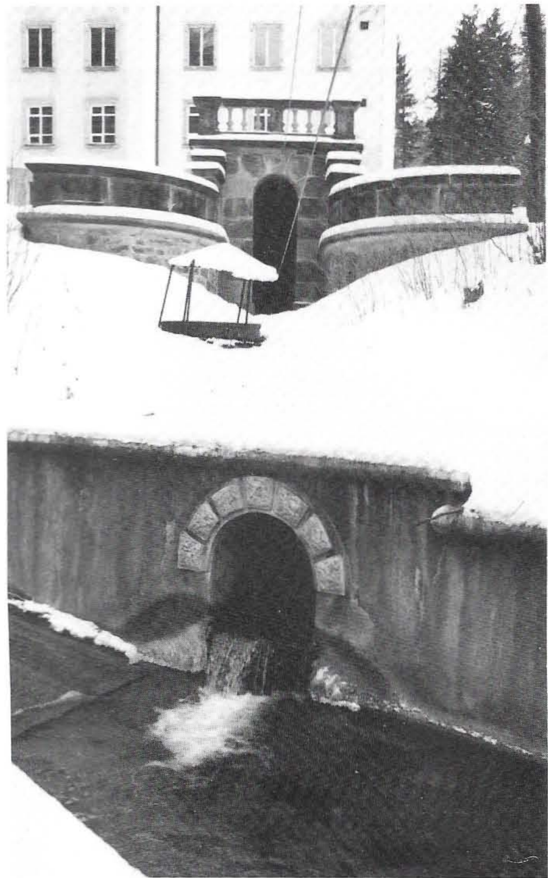
Bild 28. Kette von industriegeschichtlich wertvollen Zeugen des Industrie-Ensembles Neuchâtel: Wissenbach mit Kringelbacheindolung, gedeckter Einstieg zum Kontrollschacht des Turbinenauslaufstollens vom Fabrikgebäude, Transmissionsschlitz als integraler Bestandteil der früheren Parkanlage sowie im Hintergrund ein Teil des kürzlich durch den Kanton erworbenen Fabrikgebäudes
