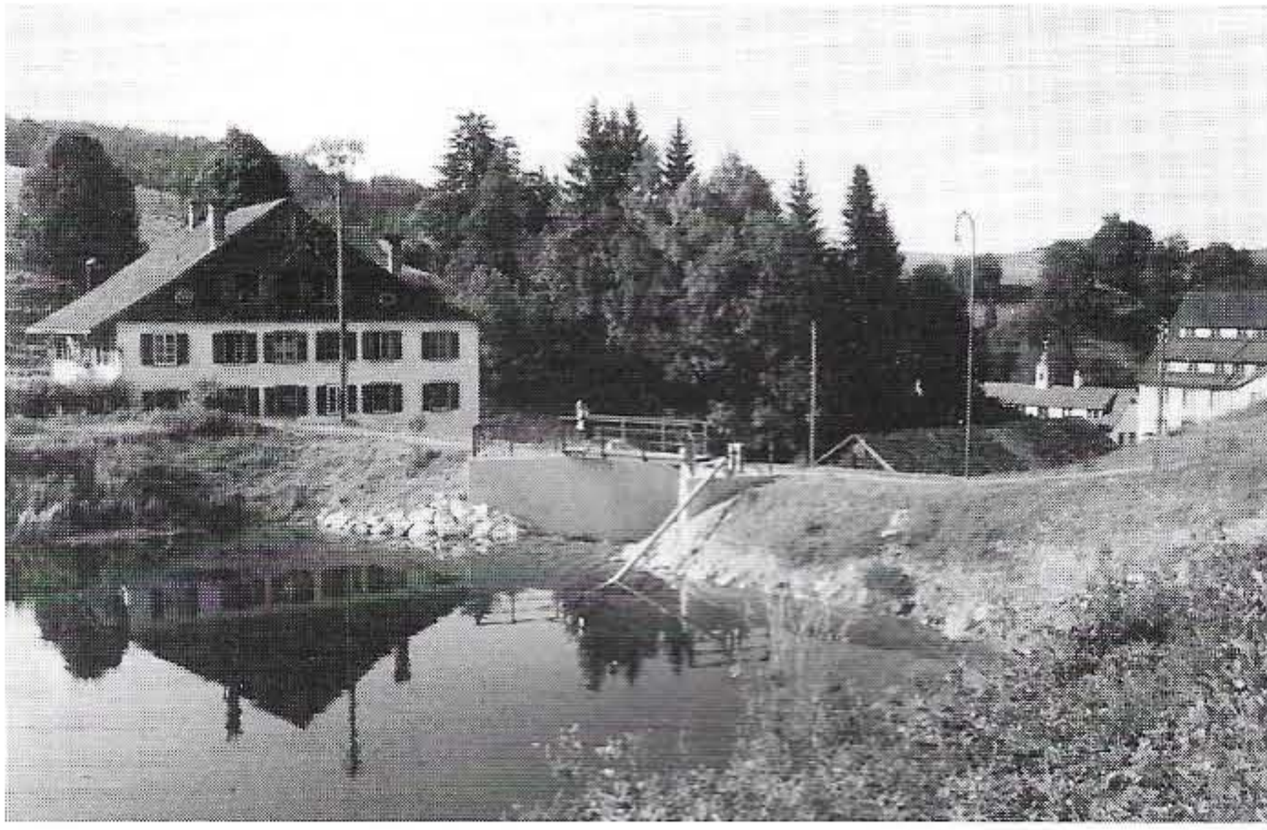
Bild 19. Erdamm Unterer Weiher nach der Sanierung im August 1989 mit der ehemaligen Mühle Müedsbach, rechts davon im Hintergrund das ehemalige Fabrikantenwohnhaus und Fabrikgebäude.
