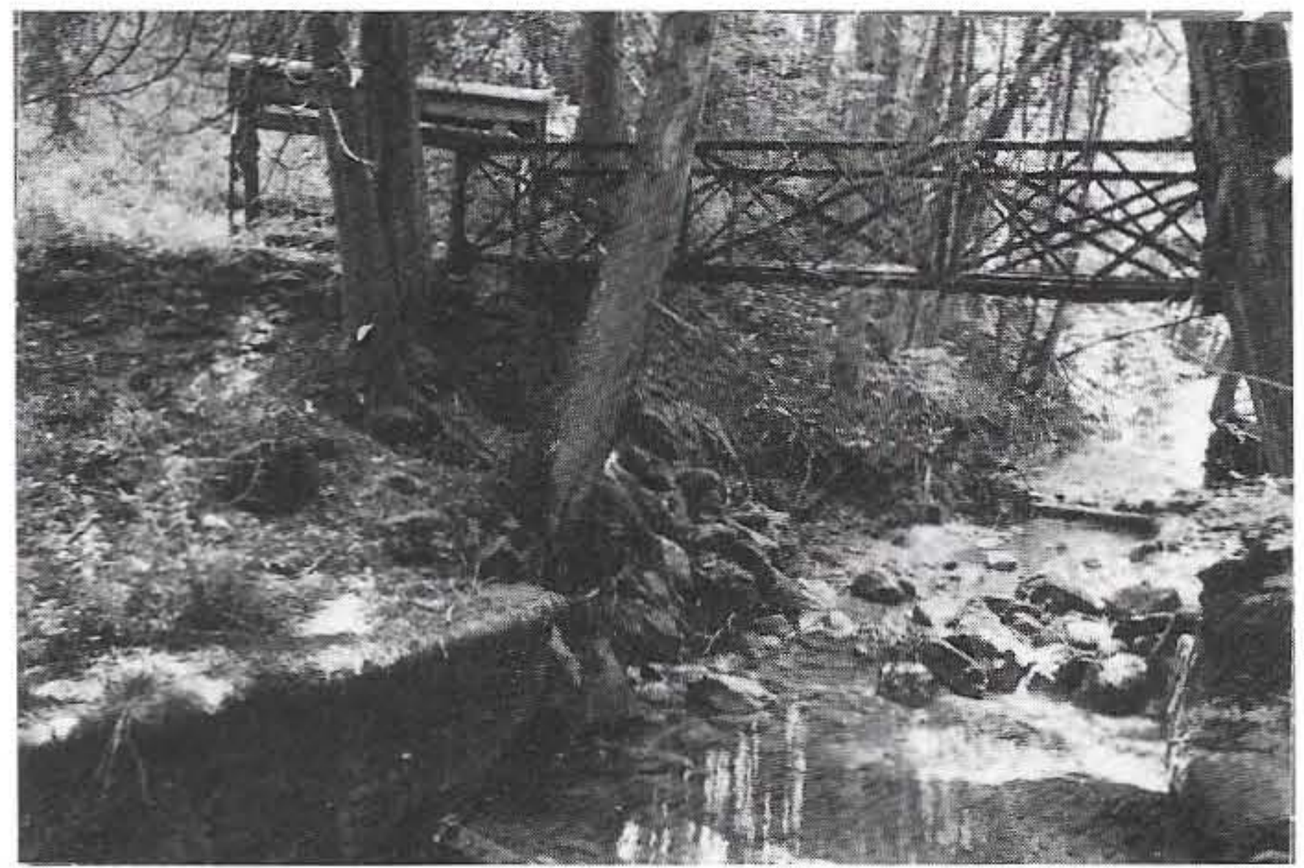
Bild 14. Das Teilstück des Wissenbachs, für dessen Unterhalt der Inhaber des Wasserrechts verpflichtet ist, vor der Instandsetzung der Ufermauern. Die Verbauungen waren teilweise eingestürzt, weshalb die Uferböschungen bei Hochwasser durch Erosion gefährdet waren.
