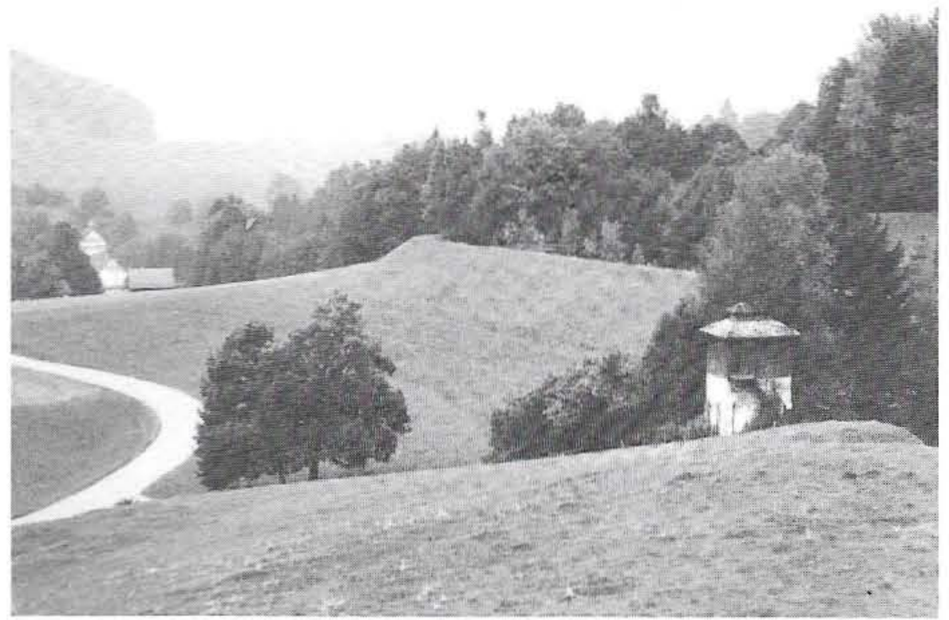
Bild 23. Der Farenbuelweiher besitzt kein eigenes Einzugsgebiet. Er wird mittels einer Druckleitung mit Wissenbachwasser gespeisen. Im Regulierturm kann der Wasserstand des Weihers eingestellt werden. Das überschüssige Wasser gelangt in den Umleitungsgraben und von dort zum Äusseren Weiher
