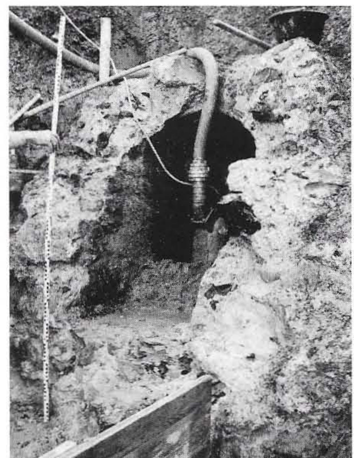
Bild 18. Angeschchnittener Grundablassstellen des Unteren Weihers. Die massive Konstruktion aus dem Jahre 1851 wies keinerlei Schäden auf und erübrigte jede Sanierung.
