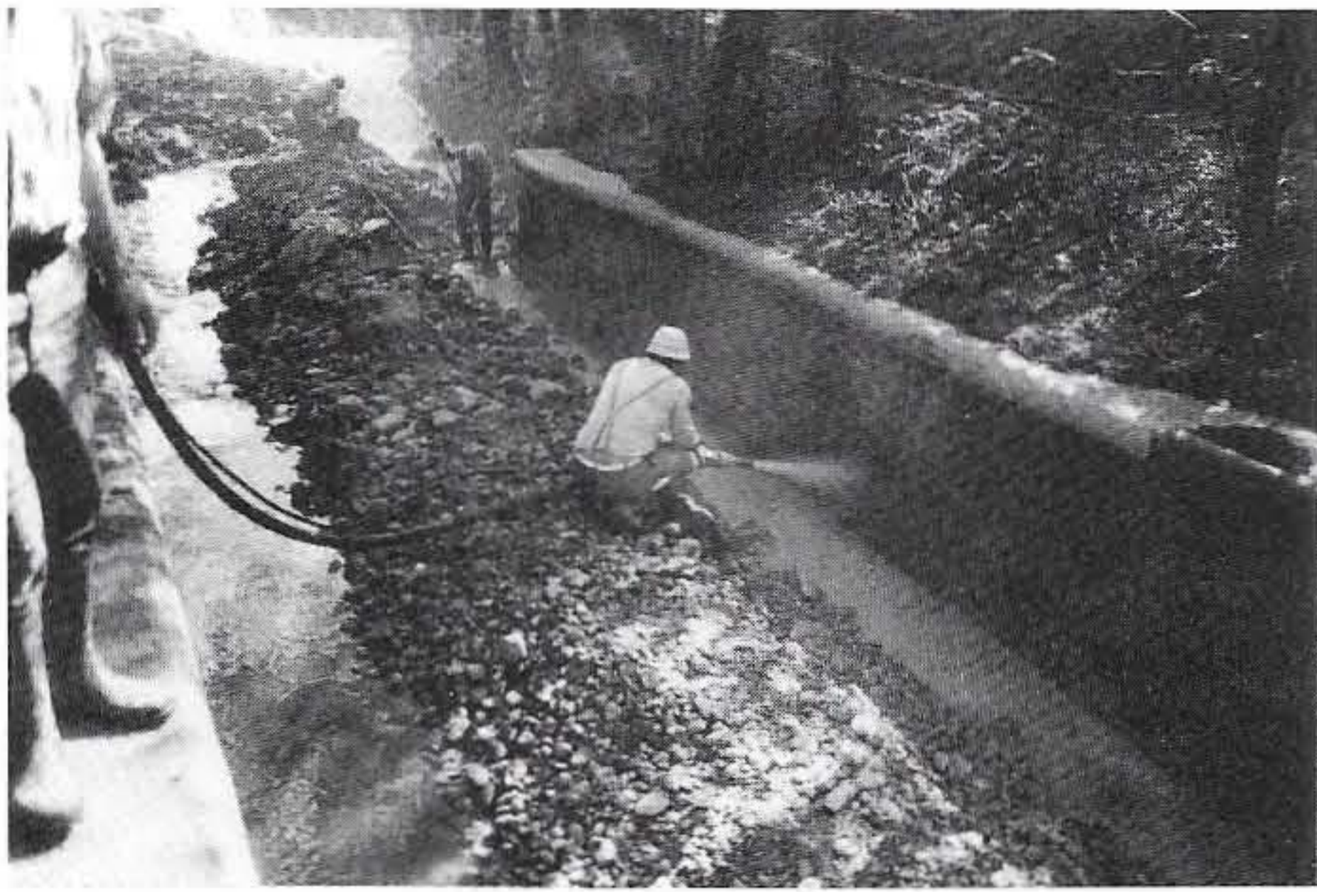
Bild 15. Aufprofilieren der teilweise zerstörten alten Ufermauern entlang der unterhaltspflichtigen Wissenbachstrecke. Die vorstehende Mauerkrone ist wiederhergestellt worden.
