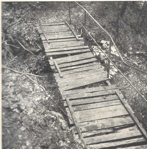
Guyer-Zellerwege vor der Instandstellung . . .
