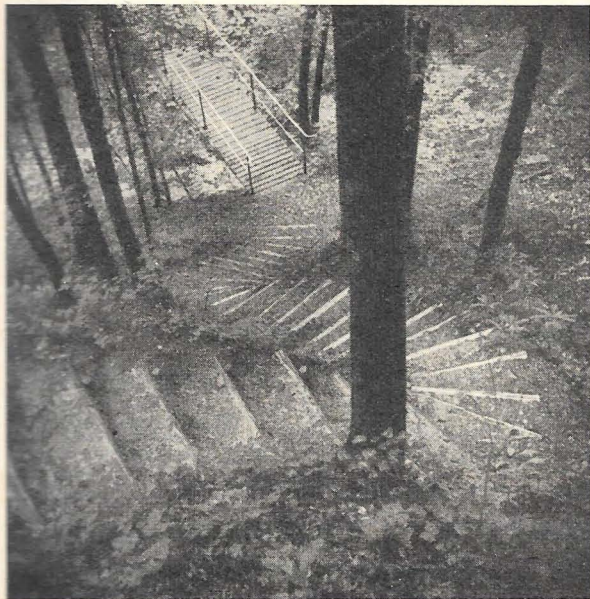
Neue Treppenstufen im Lochbachtobel
