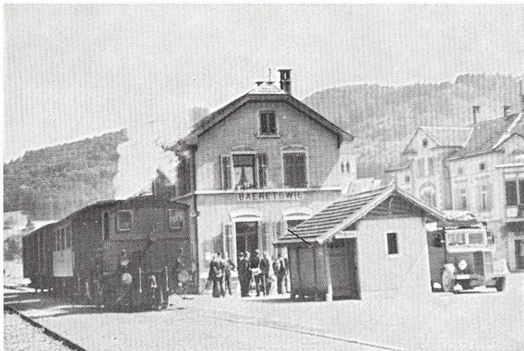
Regel Umsteigeverkehr in Bäretswil im Sommer 1946. Rechts der von Bauma eingetroffene Sattelschlepper. (Foto H. U. Würsten)
