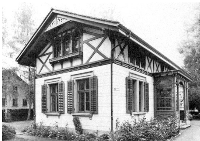
Bäretswil. Schulhausstrasse 4. Ehem. Ökonomiegebäude Vers. Nr. 997 beim Gemeindehaus. Nach der Renovation 1976.
