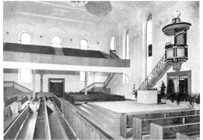
Bäretswil. Reformierte Kirche. Inneres nach der Renovation.
