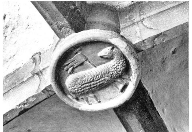
Bärenswil. Reformierte Kirche. Sakristei. Gewölbabschlussstein. Nach der Restaurierung.
