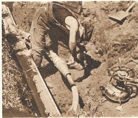
Luftdichtes Abschliessen der verbundenen Drähte
