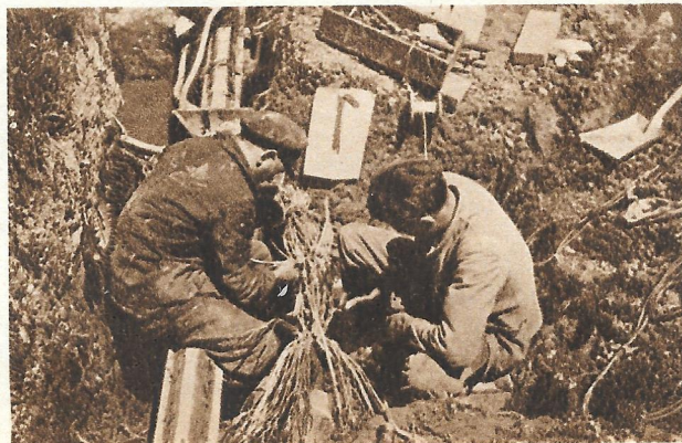
Bild rechts: Ueber 200 Einzeldrähte wurden hier zusammen verbunden
