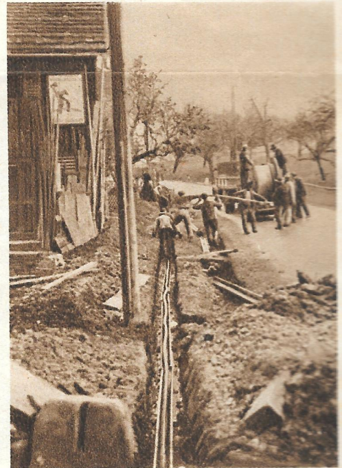
Das Legen des Kabels in die Eisenkanäle
