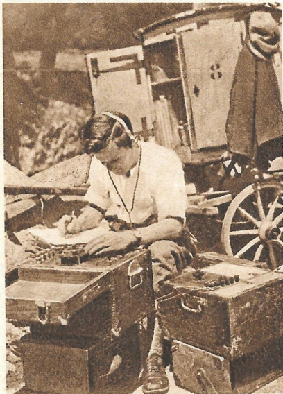
Prüfungen der Verbindungen im Kabel
