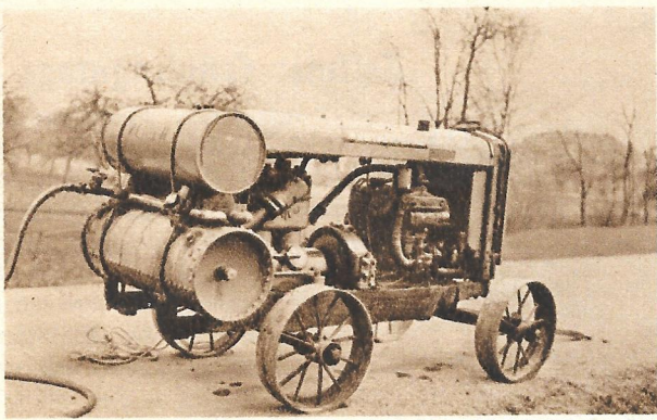
Der Kompressor, der die Bohrmaschine in Betrieb setzt
